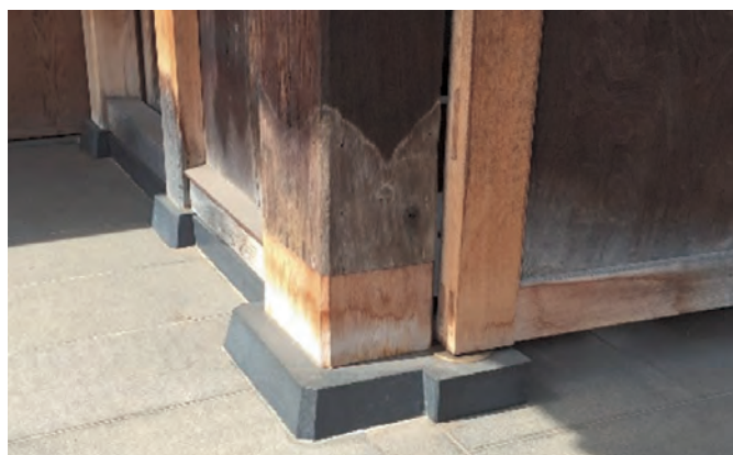
写真1 根継ぎによる修理
